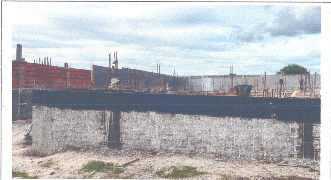
FOTO 41: Chapisco da alvenaria de embasamento - Edificação
