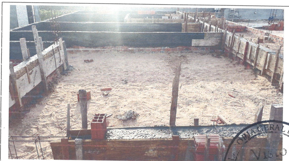
FOTO 38: Concretagem das vigas baldrames - Edificação
