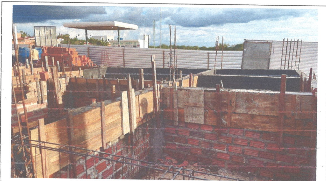
FOTO 37: Confeção das formas das vigas baldrames – Edificação
